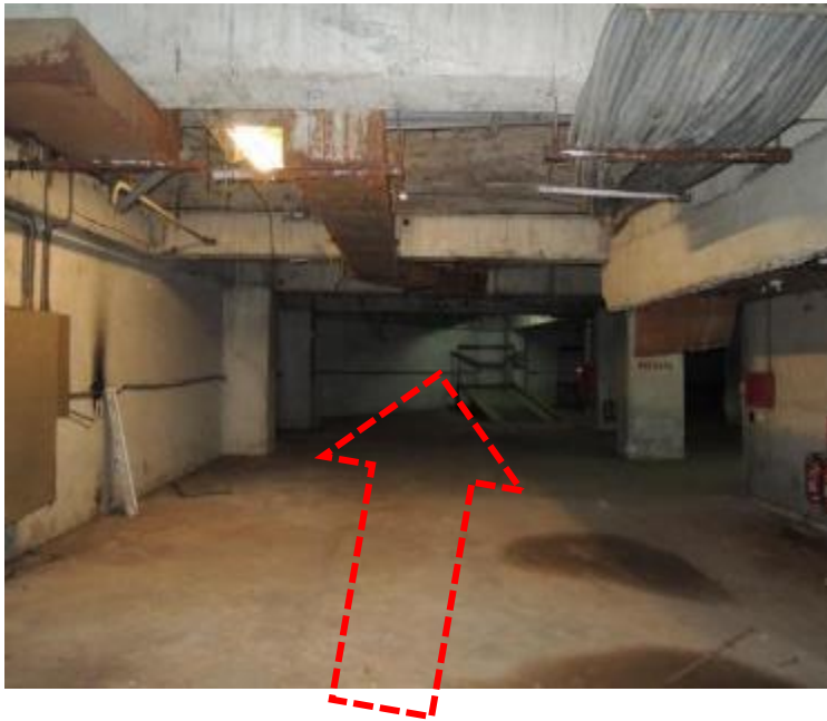
現況照片：車道
