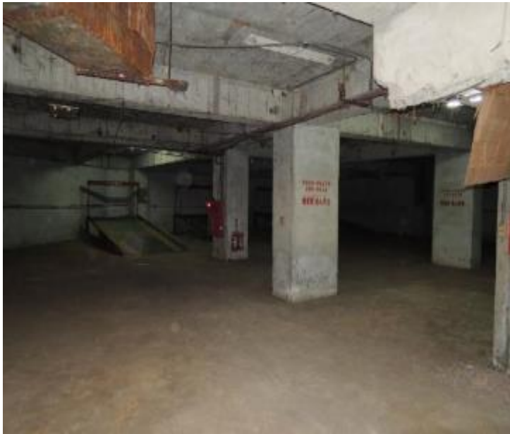
現況照片：車道
