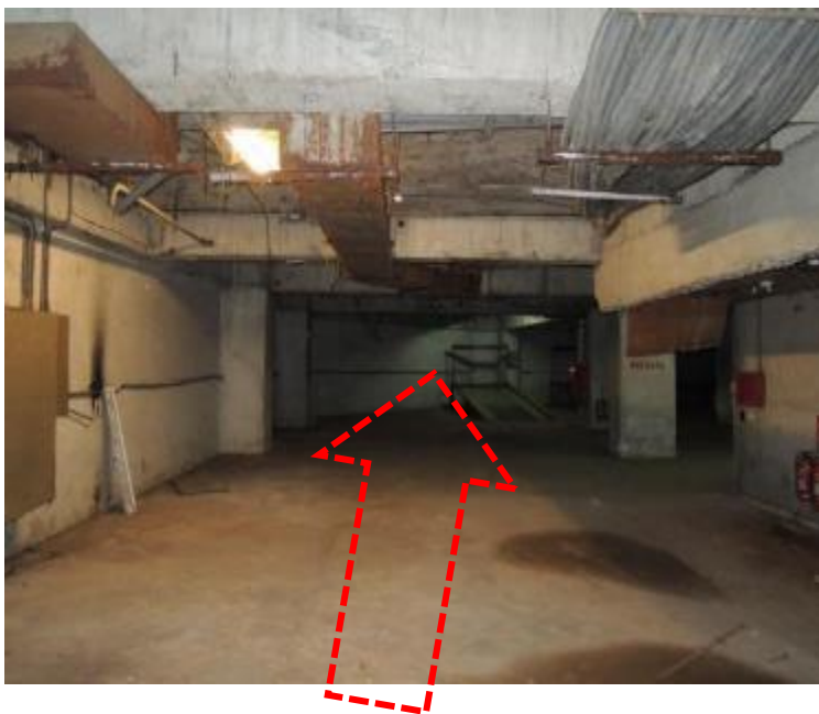
現況照片：車道
